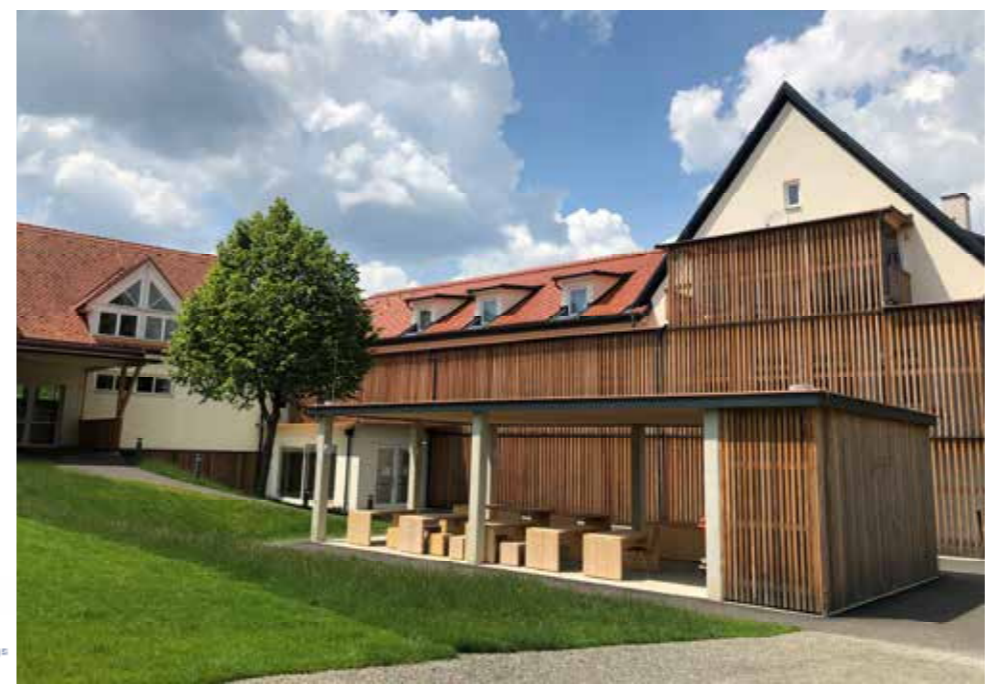
Die klimafit sanierte Volksschule Pirching am Traubenberg mit einem Sonnenschutz aus Holz und einer Freiluftklasse
